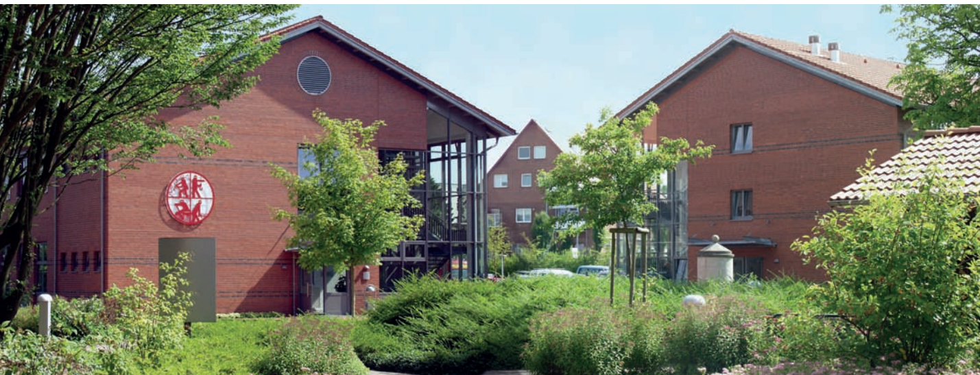
Die neuen Gebäude C (Speisesaal, Lehrsäle) und E (Bettenhaus) in der SUEDERSTRASSE
