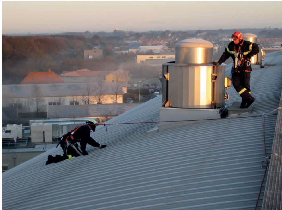
Schwindelfrei: Übung Absturzsicherung auf dem Dach der Übungshalle
