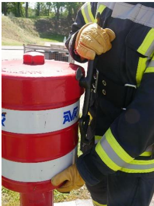
6.5.3-1 Lösen des Fallmantels
