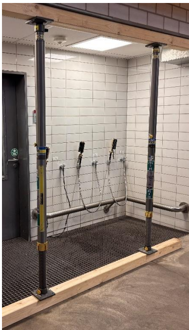
16.4.3-1 Rettungsstützen mit Schwelle und Unterzug
