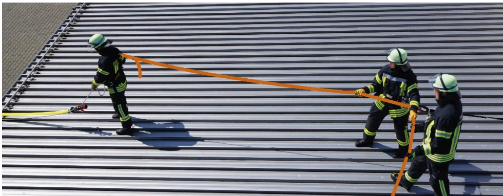
18.1.1-1 Die Einsatzkraft kann die Absturzkante nicht erreichen.
