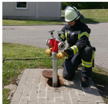
6.5.2-4 Einsetzen des Standrohres
