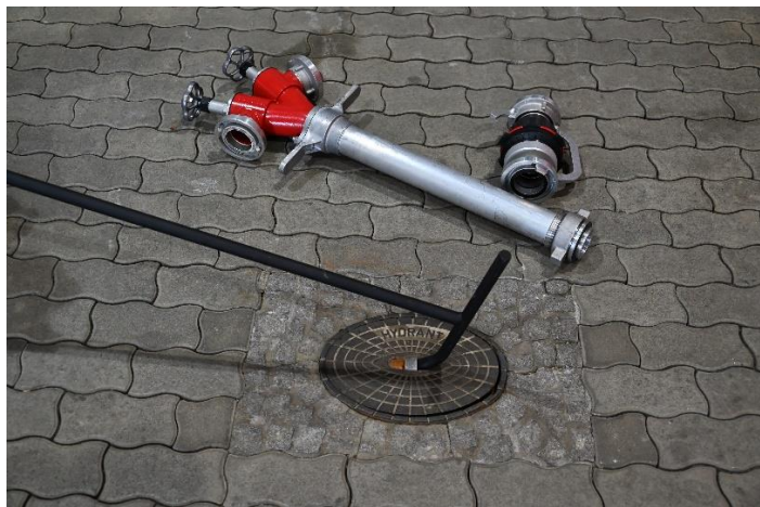
6.5.2-2 Abheben des Straßenkappendeckels
