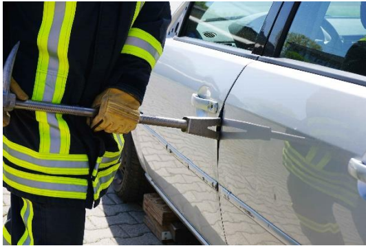
8.2-1 Spalt an einer Fahrzeugtür mit multifunktionalem Hebel-Brechwerkzeug schaffen
