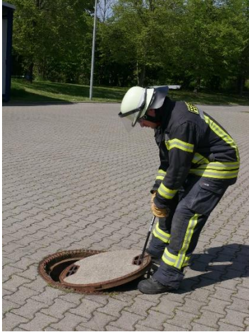
6.3-1 Öffnen des Saugschachtes durch eine Einsatzkraft
