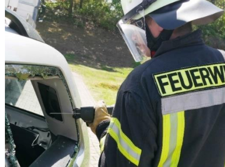
15.4-2 Elektrische Säbelsäge im Einsatz
