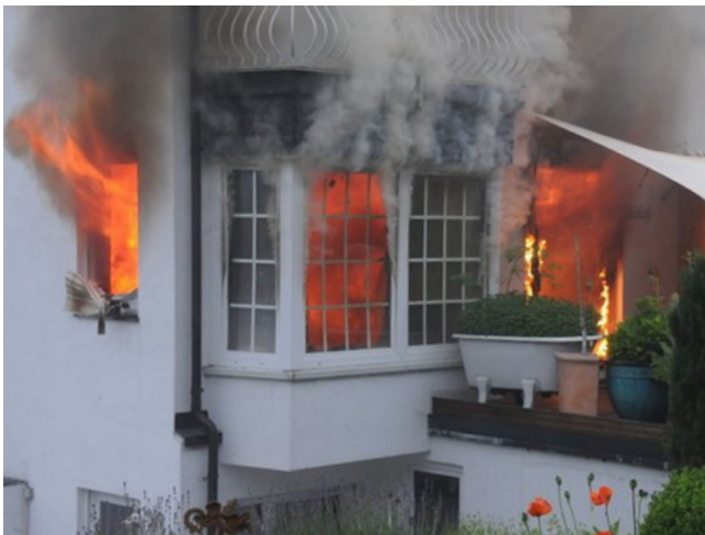
Abb. 5: Die Flammen schlagen im oberen Bereich halbflächig aus dem Fenster und zeitgleich werden die Flammen im unteren Bereich des Fensters eingezogen. Die Fensteröffnung ist somit gleichzeitig Zu- und Abluftöffnung. Der Brand ist gut ventilert.
