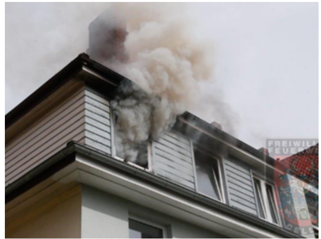
Abb. 4: Hier tritt der Rauch nach außen gerichtet aus. Es ist von einem gut ventilerten Brand im linken Teil der Nutzungseinheit auszugehen. Am linken Fenster ist ein gerichteter Strömungspfad zu erkennen. Das Fenster dient hier als Abluftöffnung. Durch den austretenden Rauch in den anderen Fenstern der Nutzungseinheit ist die Richtung der Brandausbreitung, sowie erste Hinweise auf die Raumgeometrie abzulesen.
