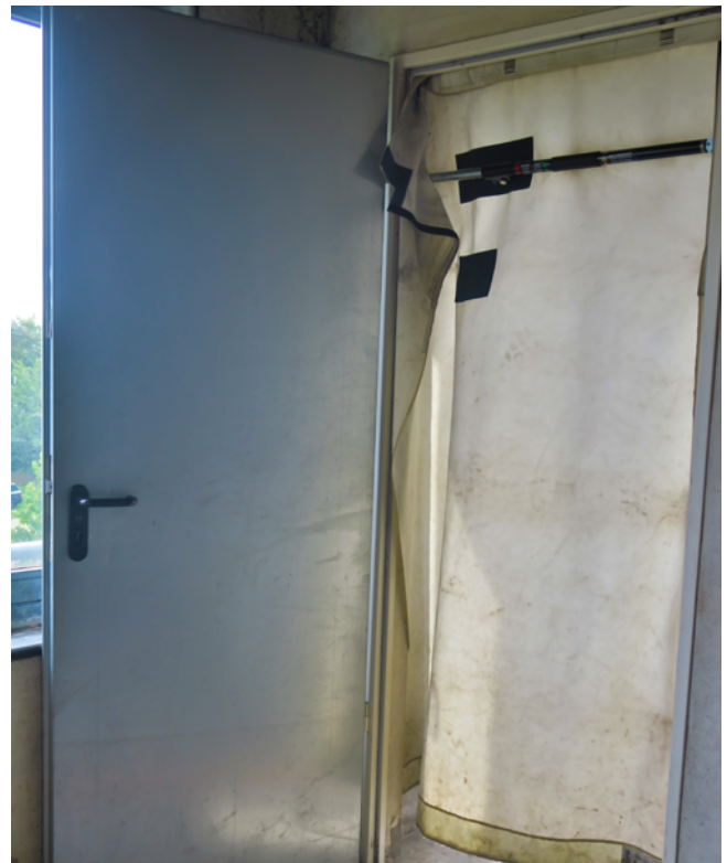
Abb. 34: Der mobile Rauchverschluss ist gesetzt und der Trupp geht vor.
