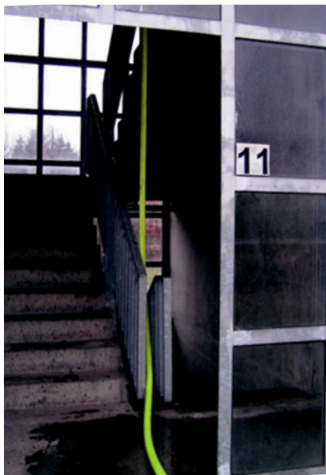
Abb. 18: Verlegen der Schlauchleitung durch das Treppenauge
