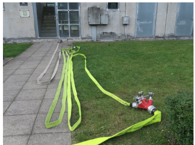
Abb. 16: Die fertige Schlauchreserve mit Hohlstrahlrohr und Verteiler
