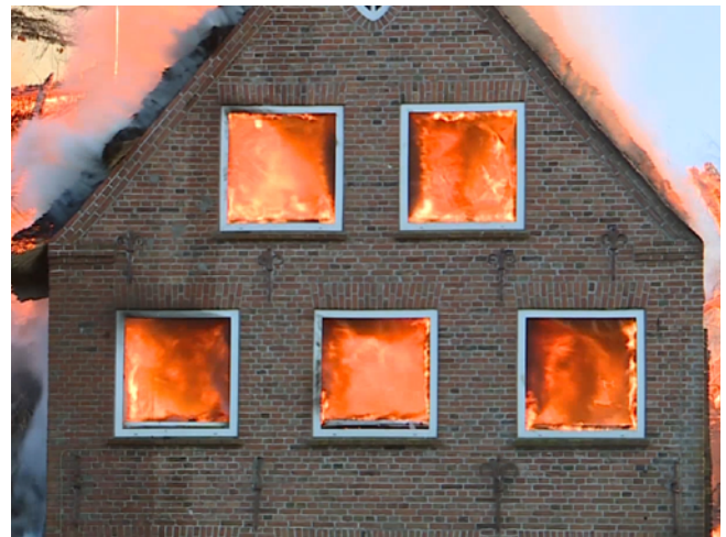
Abb. 6: Die Flammen werden in die Fensteröffnung gezogen. Ein gerichteter Strömungspfad ist zu erkennen, die Fenster dienen in diesem Fall als Zuluftöffnung.
